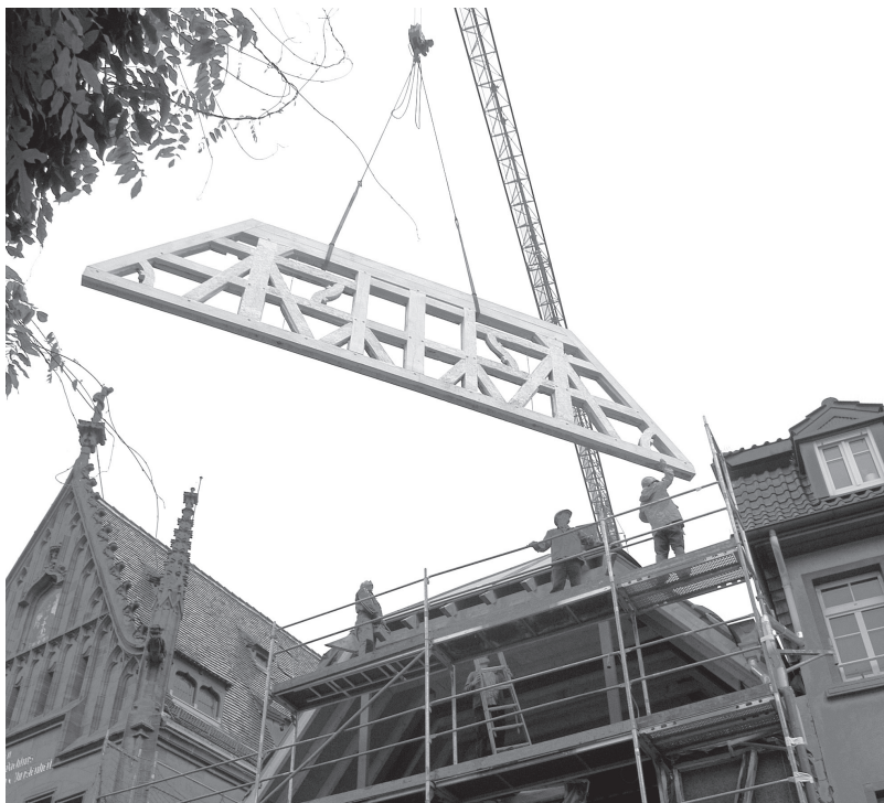
Am Vormittag des Richtfesttages wurde noch das Giebel- fachwerk am Haus angebracht
