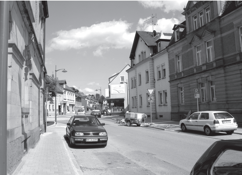
Von der Bahnhofstraße bis zum Gottesackertor wird am Wochenende der neue Fahrbahnbelag aufgebracht
