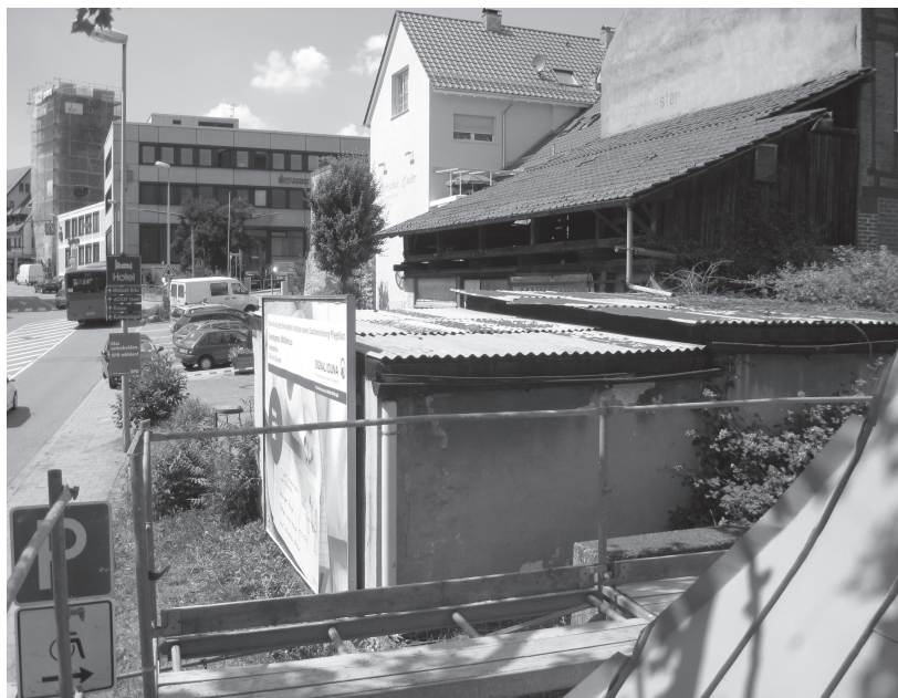
Am Mittwoch wurde mit dem Abriss der Hüttenlandschaft begonnen
